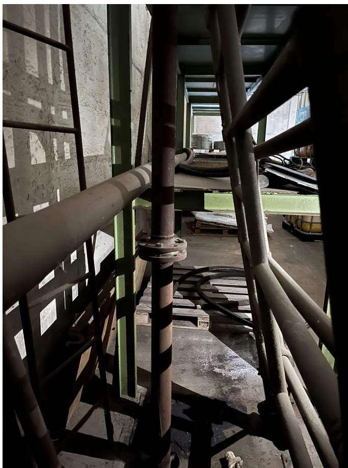
Obrázek 1 Napojovací bod požárního rozvodu
